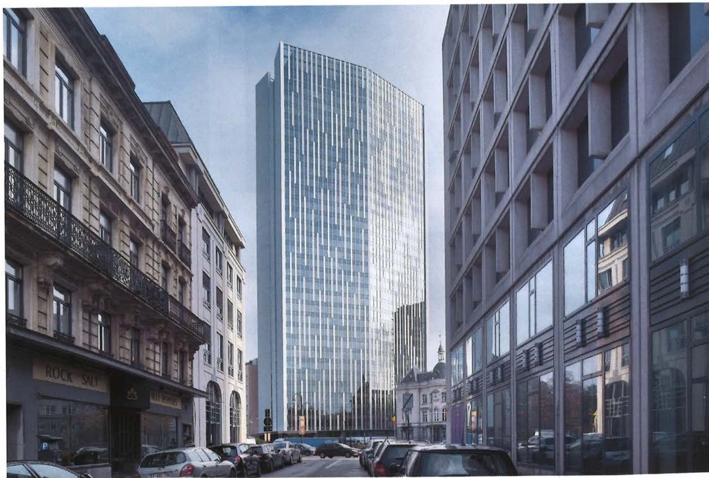
Nuevo aspecto de la fachada de la Torre Astro tras su renovación.
