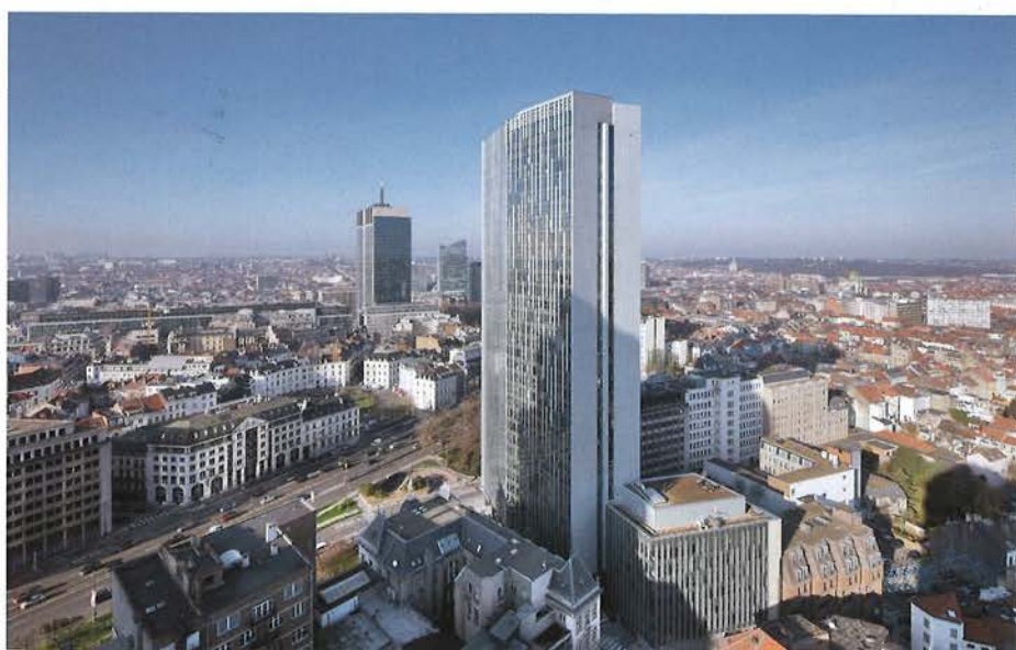
Vista general del edificio rehabilitado.
