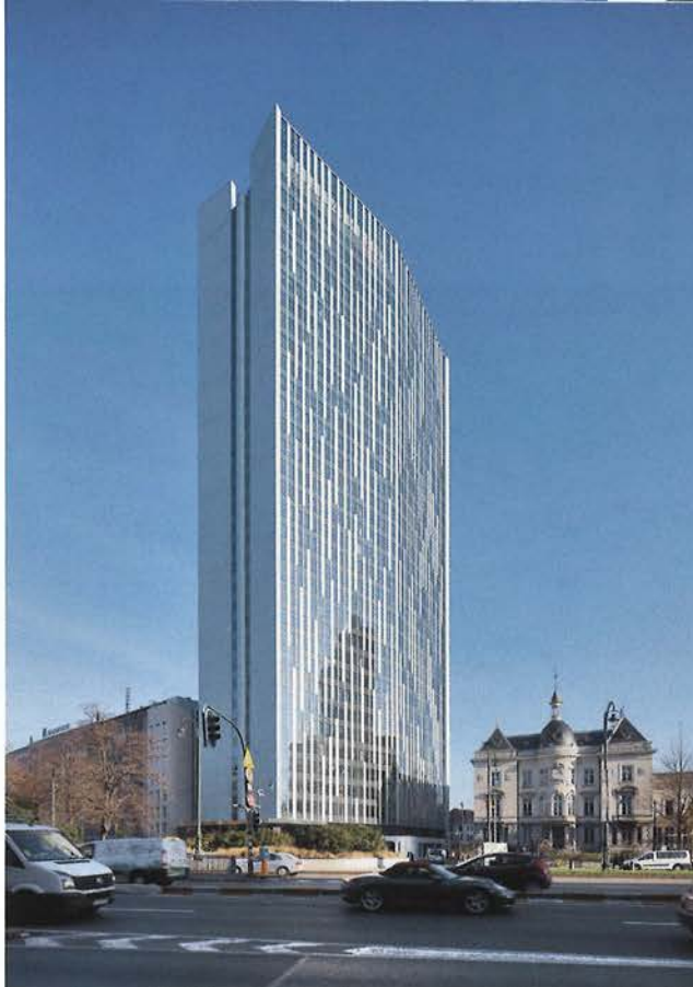
La Torre Astro es el edificio eficiente más alto de Europa, con 113 metros.
