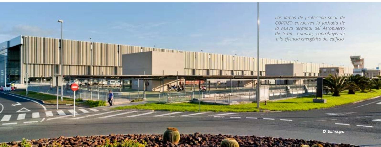
*Las lamas de protección solar de CORTIZO envuelven la fachada de la nueva terminal del Aeropuerto de Gran Canaria, contribuyendo a la eficiencia energética del edificio.*
