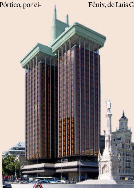
Las Torres de Colón, antes Torres de Jerez, de Antonio Lamela, fueron todo un reto tecnológico en 1976, ya que se construyeron de arriba a abajo.
