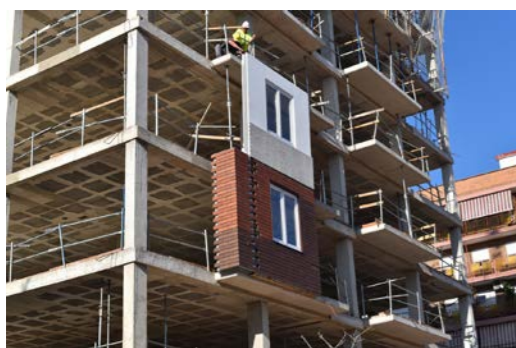
Dos paneles de fachadas industrializadas de Spans siendo colocados en un bloque de viviendas en Valencia.
