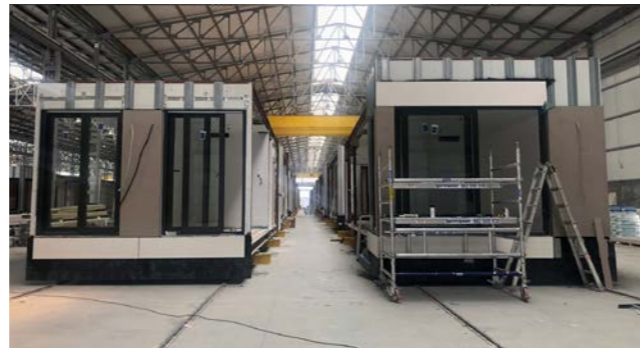
Uno de los módulos de las viviendas industrializadas de la promoción Etheria de AEDAS Homes en El Cañaveral, Madrid.
