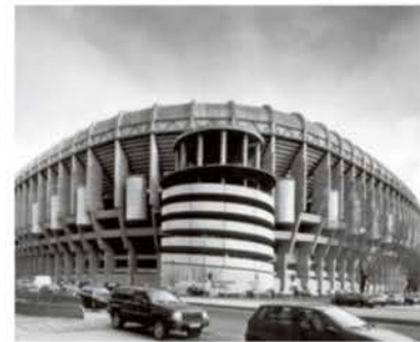
El estudio en 1966, las Torres de Colón en la versión original de Lamela en los setenta, y su ampliación del estadio Bernabéu en los noventa, que incluyó las cuatro torres esquineras que permiten evacuar en menos de 10 minutos.
