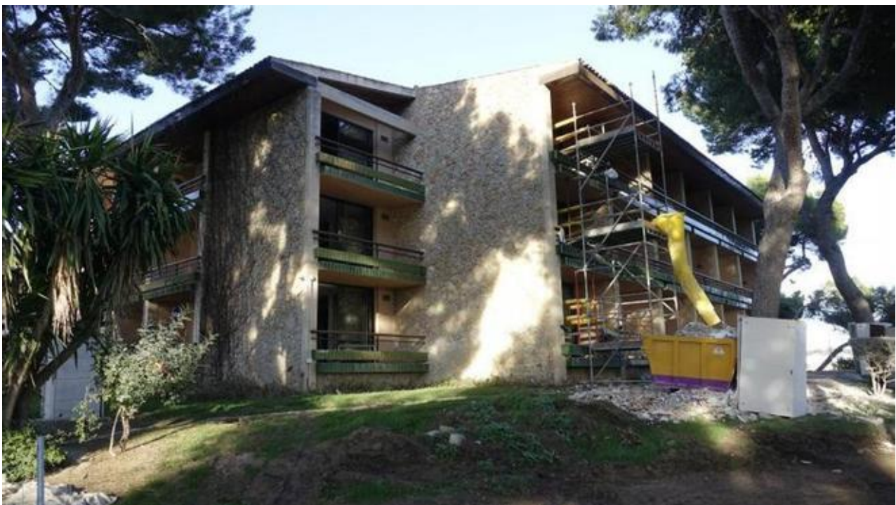
Trabajos de demolici n en el hotel Punta Negra. | JUAN LUIS IGLESIAS
